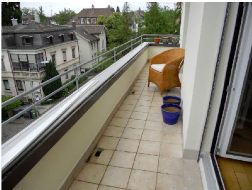
Gemauertes Balkongeländer mit angeschraubten Metallröhren.
